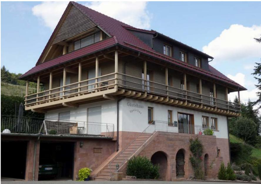
Holzbau im Ortenaukreis: Das neue Gästehaus des Hotel Kreuz in Prinzbach war zuvor ein Speicher, der bis auf die Kellermauern abgetragen wurde. Darauf verbaute Rombach Außenwände und Holzrahmen-Innenwände sowie die Dachelemente. Verteilt über zwei Stockwerke plus Dachausbau entstanden acht Gästezimmer.
