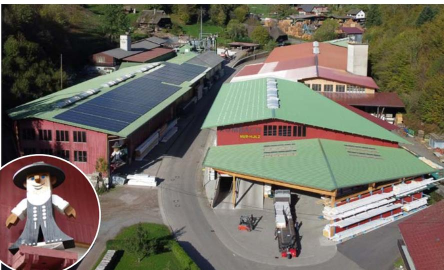
Die Übernahme eines Firmengeländes erlaubte Rolf Rombach die Unterbringung seiner beiden Betriebe auf einem Grundstück. In der Halle links wird gehobelt und abgebunden, davor grüßt eine Zimmermannsfigur aus Holz. Rechts befindet sich die Fertigung der Holzrahmenelemente (vorn) sowie hinten von Massivholzhäusern.
